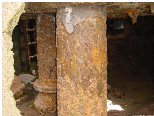
Kellergewölbe der Mühle
